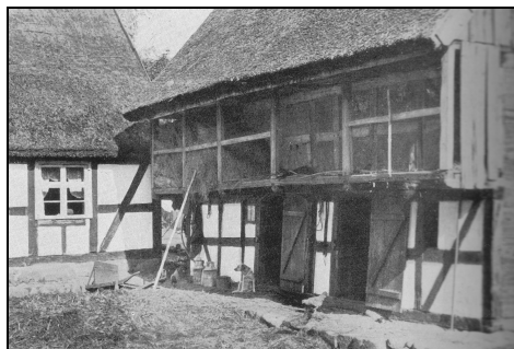
Fot. 6. Galeria w budynku gospodarczym zagrody czworobocznej – Klein/Gross Justin (Kreis Kammin, 1938)
