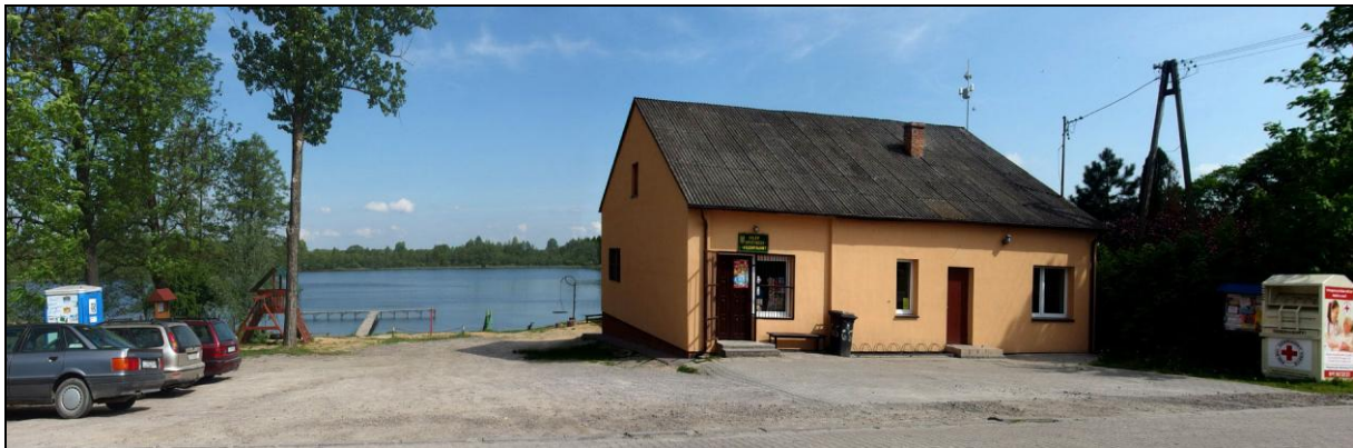
Fot. 5. Otoczenie sklepu i plaża w Głębokim, gm. Cyców. Przykład powiązania przestrzeni publicznej z główną drogą, jeziorem i usługami (niestety tyłem do plaży). Minusem jest brak zieleni i nawiązań do lokalnej tradycji.
