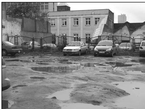
Fot. 1. Parking z nawierzchnią gruntową po deszczu.
