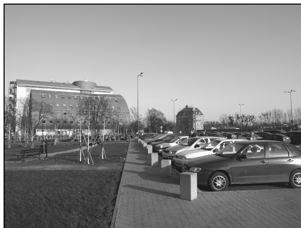
Fot. 4. Betonowe zapory na skraju strefy dla pieszych.
